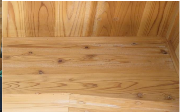
教室の天井 「アカネ材の穴を詰めて使っている。
